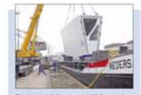
R auf aufs Schiff: Eines der rund 150 Tonnen schweren Stahlteilens für über bis zu 100 Meter hohen Arch. Am Kai wartet die „Niederbarchen“, um die ungewöhnliche Fracht nach Hamburg zu bringen.
